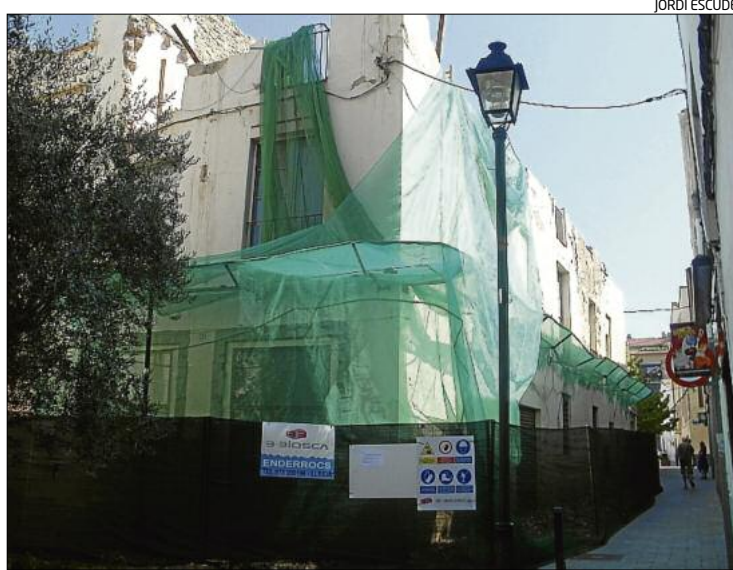
Operatiu d'enderroc de l'edifici, situat a la plaça de la Verdura
